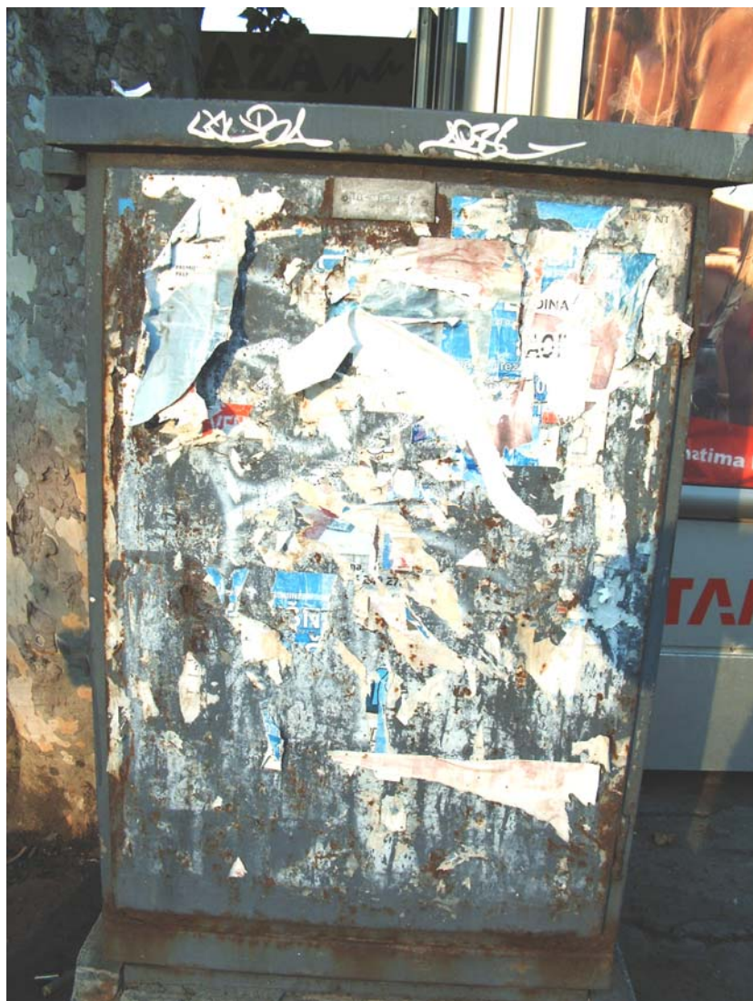
Slika 3. Spoljašnji izgled napojno–komandnog ormana ROR–6
